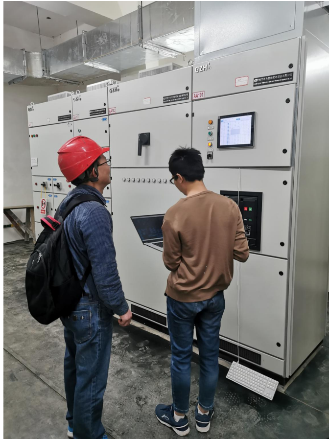
图：学校教师在设备安装现场调试
